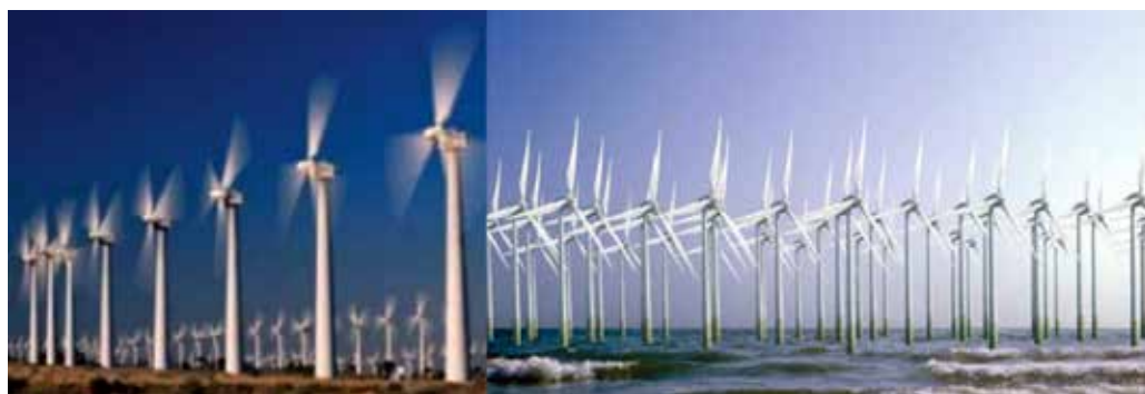
Fig. 6. (a) Parque eólico en tierra. (b) Parque eólico situado en el mar
