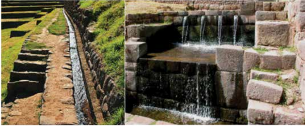
Fig. 9. (a) Fotografía mostrando una porción del canal (de 750 metros de largo) que trae el agua a Machu Picchu. (b) Foto de una de las “escalera de fuentes”, a lo largo del canal
