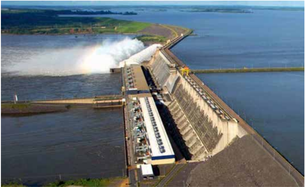
Fig. 14. Presa hidroeléctrica en el río Tocantins ubicada en el condado de Tucuruí en Brasil
